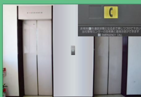
エレベータの非常通報電話の取付工事
