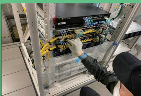
サーバールームの配線工事
