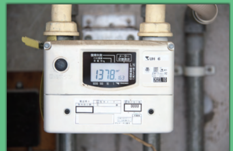
ガス検知メータの取付・回線接続工事
