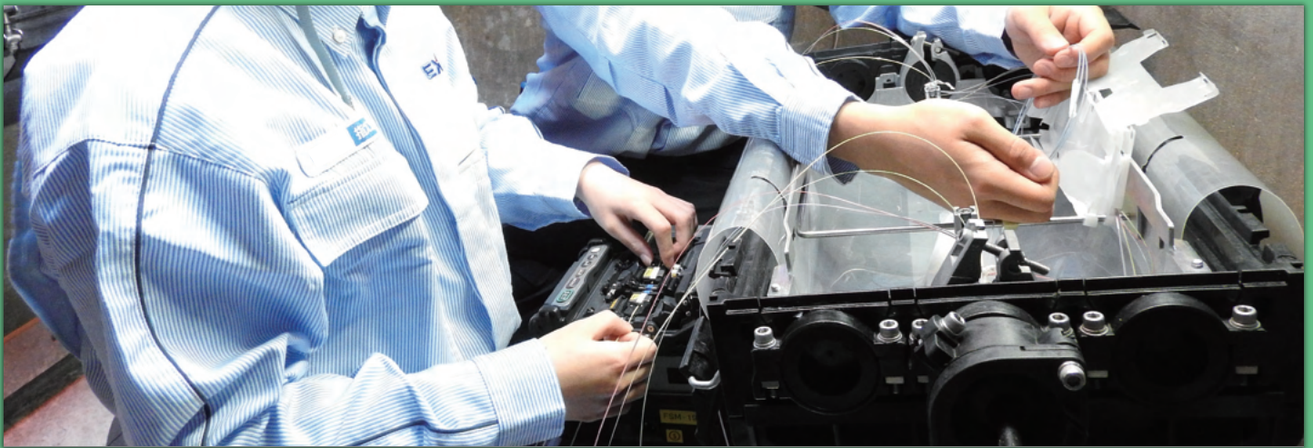
LAN ケーブルや光ケーブル接続工事
