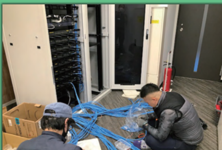
オフィスレイアウト変更に伴う LAN 工事
