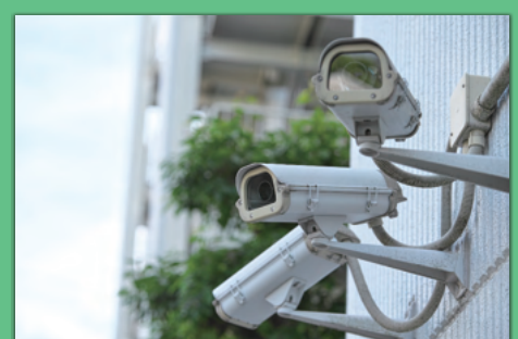
遠隔監視カメラの接続工事や保守・メンテナンス
